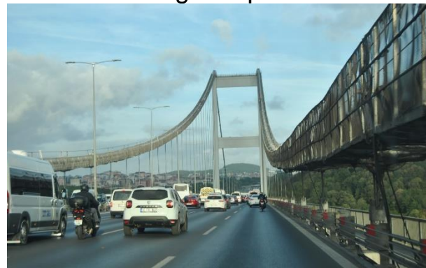
アジア側から欧州側へ同じ橋を帰っているところです。
