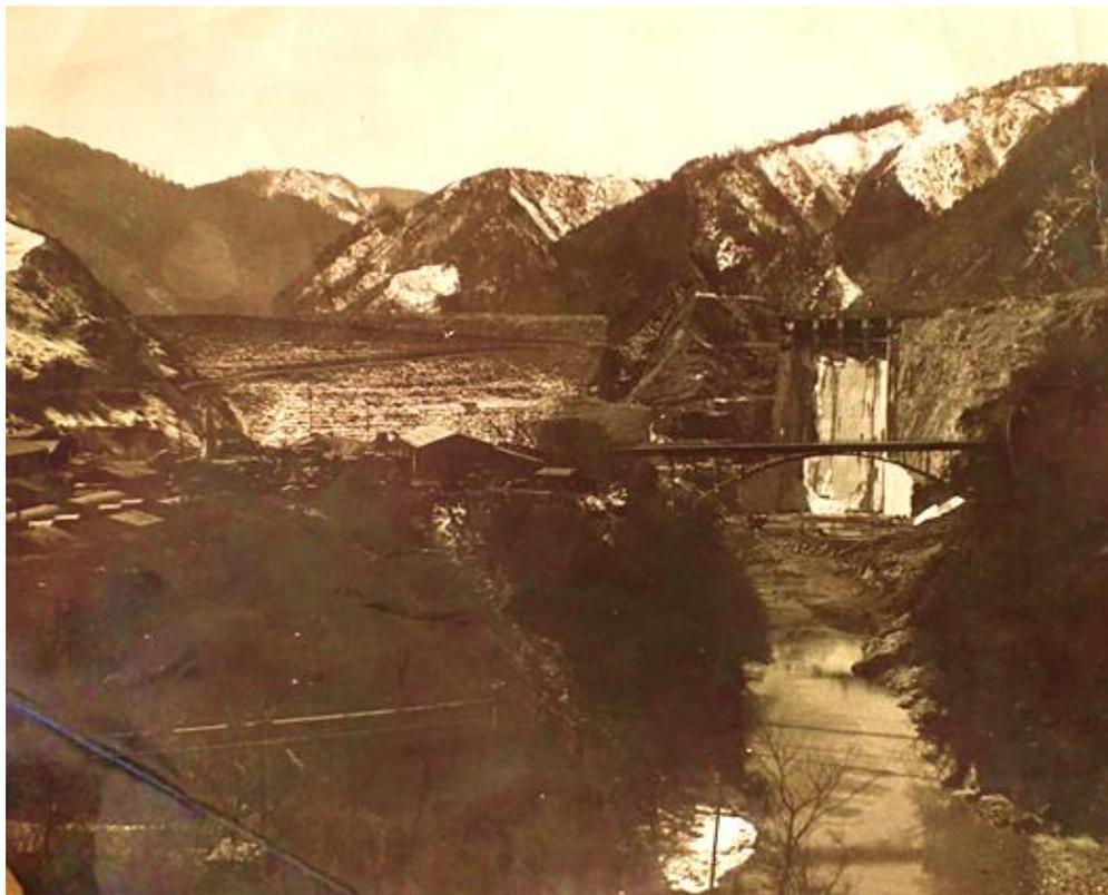
写真は愛知用水公団牧尾ダム築堤工事の様です。
