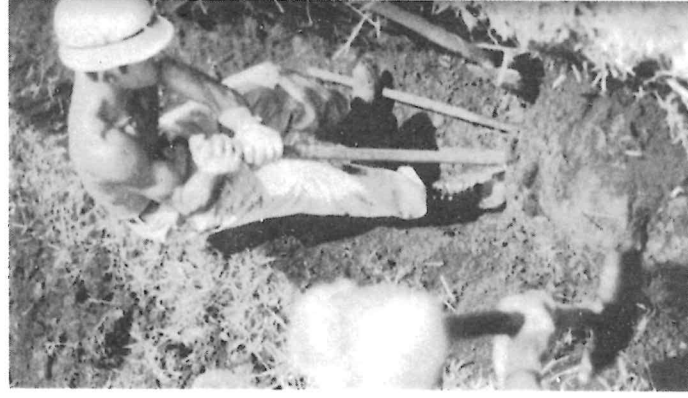
基礎工事 水道工事に取り組む隊員
